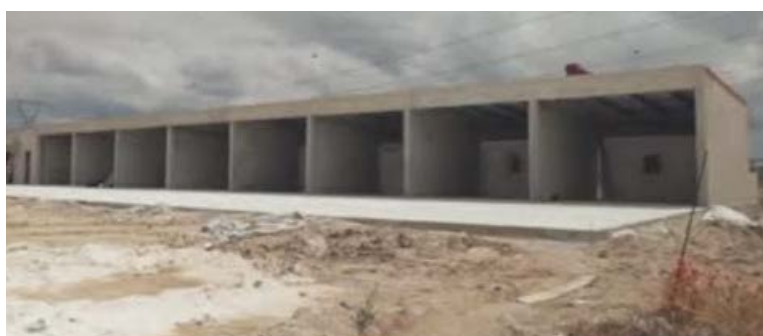
A área que está a ser intervencionada abrange cerca de 3,5 hectares e será ligada por uma ciclovia à zona poente
