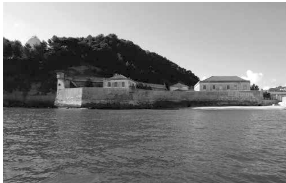
A recuperação e adaptação do forte deverá durar cerca de três anos
