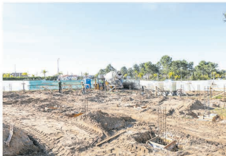
O novo mercado de Brejos de Azeitão já se encontra em construção
