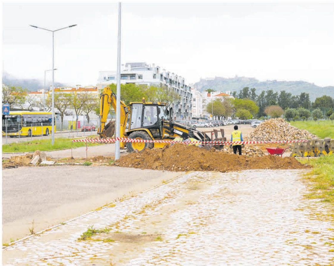
Na Rua Eng o Henrique Cabeçadas, a obra, já no terreno, permite melhorar a mobilidade na cidade
