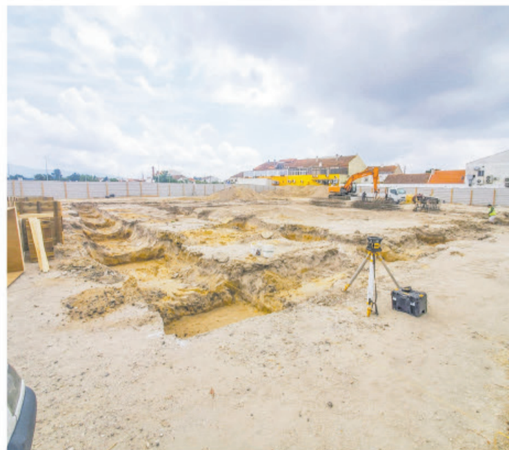
A obra, na Rua de São Gonçalo, já está a decorrer
